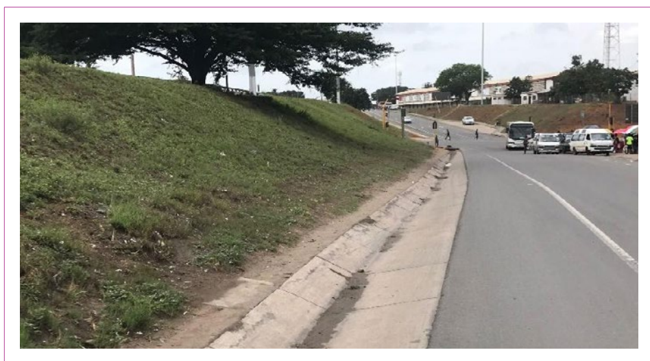
Figura 7-6. Valeta de pé de talude
