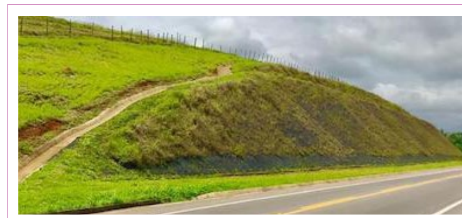
Figura 7-5. Vala de crista de talude
