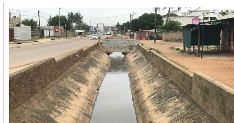
Figura 7-4. Vala adjacente ao pavimento
