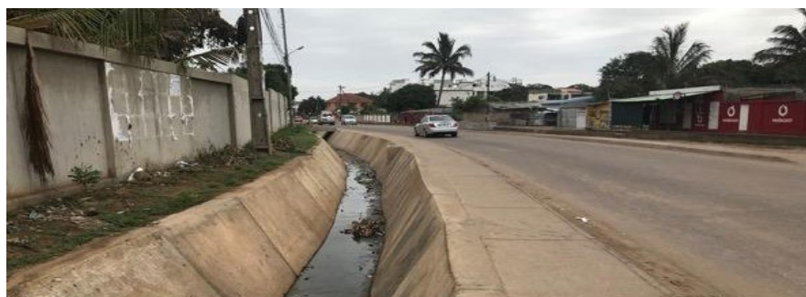
Figura 7-3. Vala de bordadura de passeio
